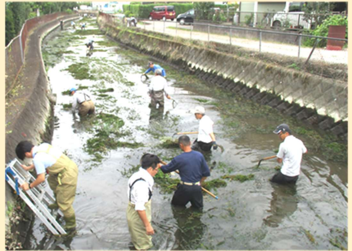
写真1: 藻狩り作業(従来の駆除方法)
