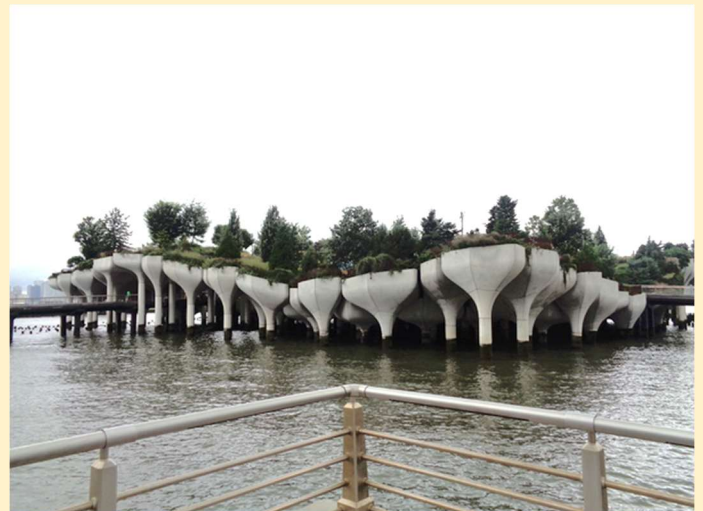
写真：リトル・アイランド(Little Island at Pier 55)の全景
