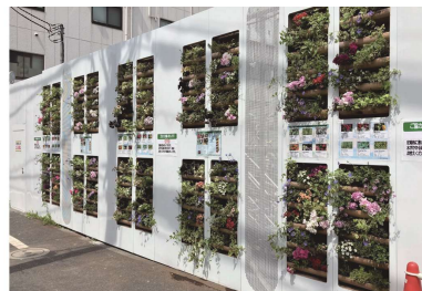
ホテル建設現場仮囲い
