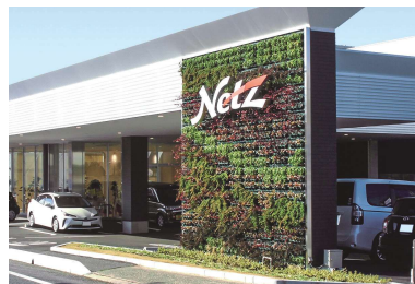
店舗(福岡県福津市)
