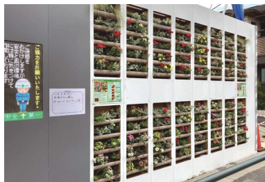
マンション建設現場仮囲い
