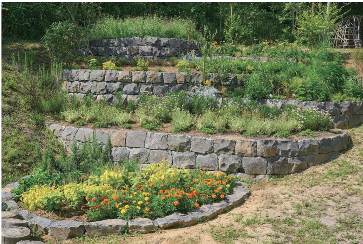
●八木山テラスの斜面を活用した段々畑。土留には、仙台城の石垣にも使用された三滝玄武石が使われた
