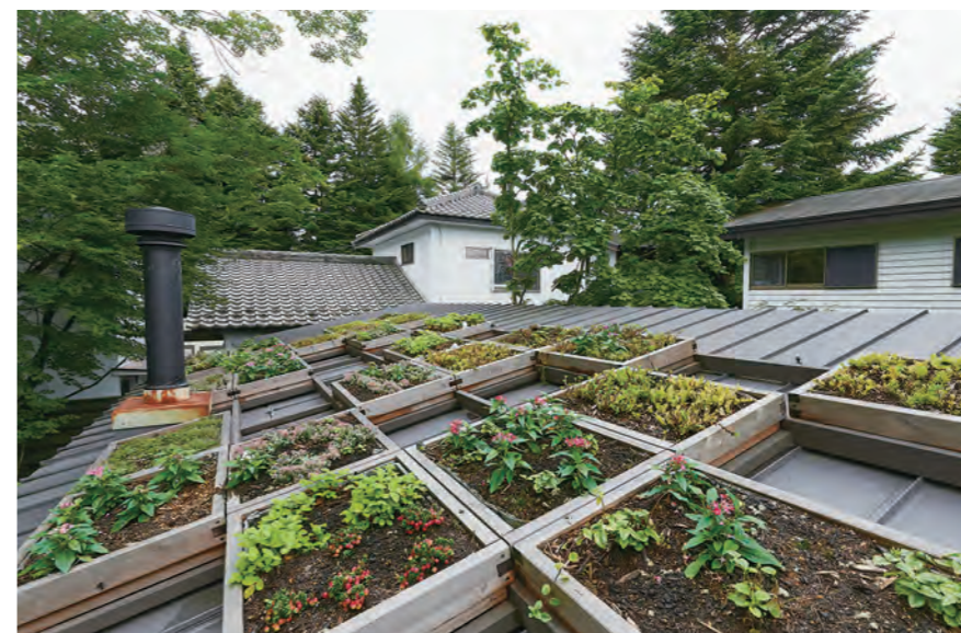
●レストランの屋根上に、パッチワークのように配された「パレット状緑化コンテナ」
