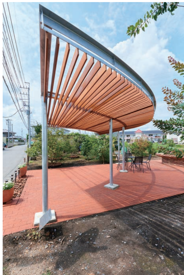
●「つつじガーデン」の中心的空間となるあずまや。アールを描くルーバーがほどよい木陰をつくる
