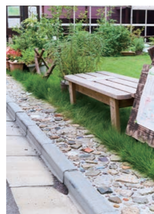
●ひろばと公道の境界はガラ舗装がほどこされている。これも道に泥を出さない工夫の一つ
