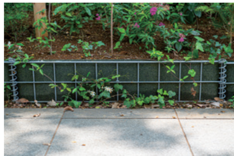
●蛇籠じたいにツタが巻きつき、いずれツタに覆われる
