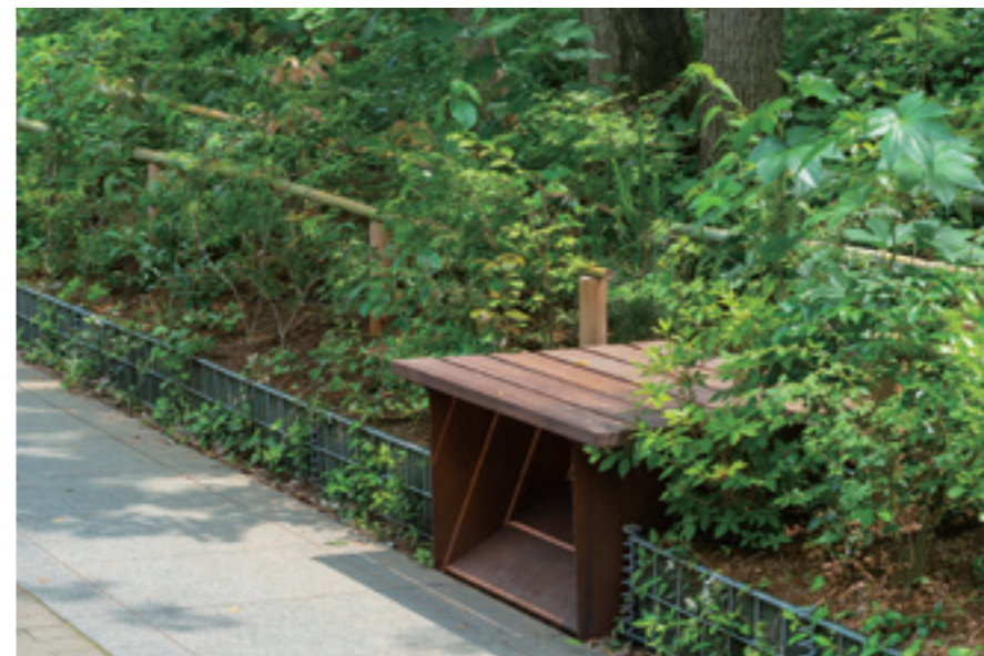
●排水マスの上部に置かれた照明内蔵のスツールベンチ。左右に見えるのは土留用の蛇籠
