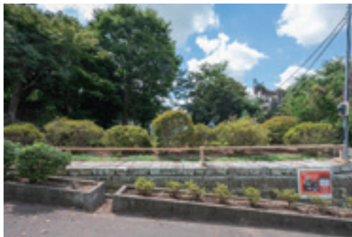
●竜巻被害により倒壊した大谷石の塀は、土留を兼ねて横詰みに。敷地内外の見通しがよくなった
