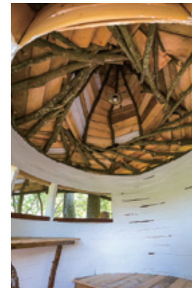
●自然の枝を使った伝統的な工法を用い、頑丈につくられている
