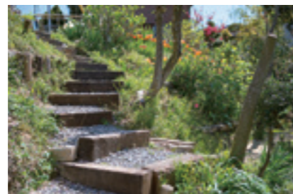
●回遊性に配慮した木製の階段は、鉄道の枕木を使用した
