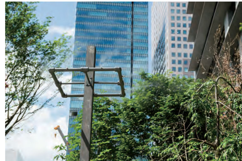
●高さ3mのボール式のドライミスト。 午後からの日差しを受けるコミュニティ空間周辺に配置されている
