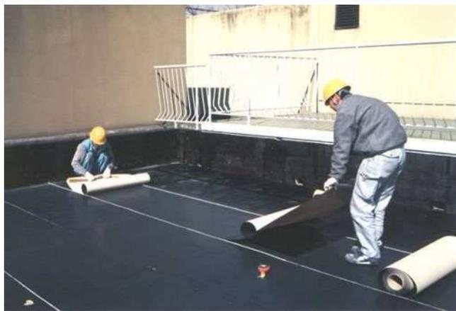
③ 改質アスファルトシート防水常温粘着工法で改修
