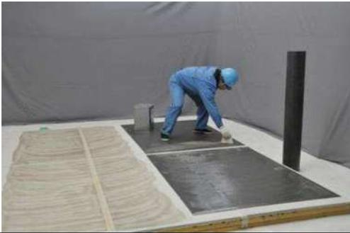
・塩ビシート防水接着工法: 下地とシート裏面に接着剤を塗布
