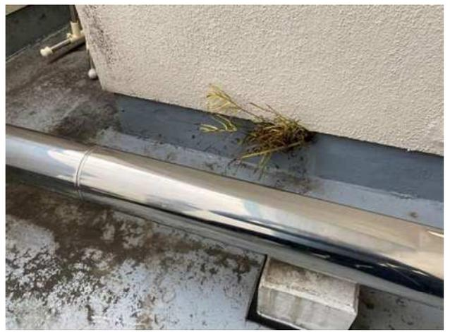
・塗膜防水の端部剥離部に繁茂する植物の事例・・・端部剥離部に雨水が溜り、植物が繁茂した不具合事例。
