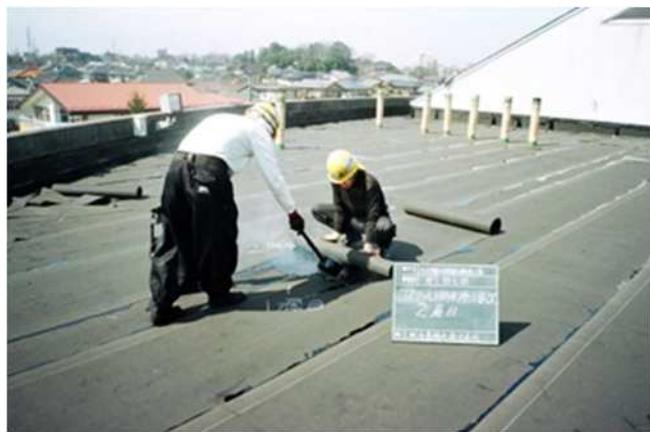
② 改修防水層施工：アスファルト防水熱工法
