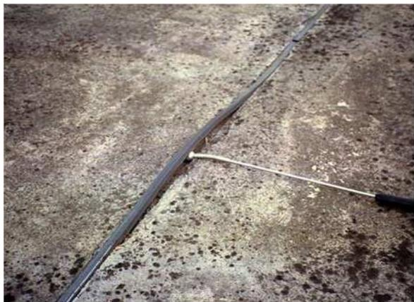
・平面部:コンクリートの伸長により伸縮目地が突出した事例
