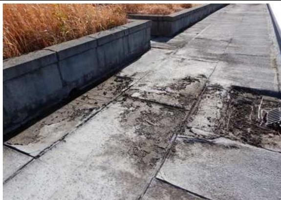
・ドレン廻り:緑地帯から流れる土埃を含んだ雨水が防水層表面の剥がれを誘発した事例
