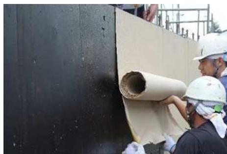
・常温粘着工法: 地下外壁での施工風景
