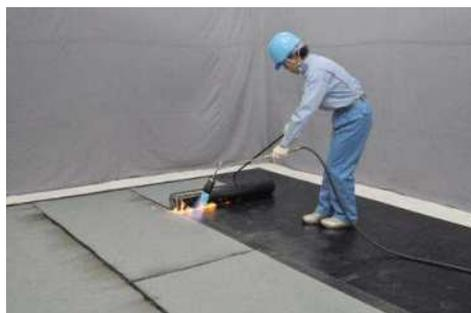
・トーチ工法: 後退法による施工。後ろ向きに進むため、屋上では突起物などにつまずかないように注意
