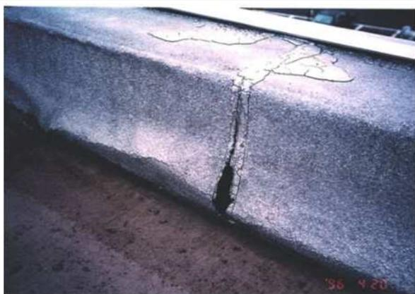
・立上り部:保護コンクリートの立上り際に緩衝材が無く、熱膨張した保護コンクリートが防水層を押しジョイントが口開きした事例
