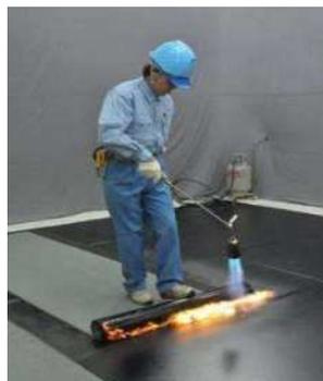
・トーチ工法: 前進法による施工。十分にアスファルトが溶けているかの確認が必須
