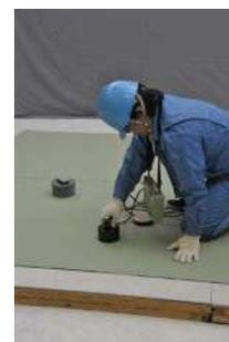
・塩ビシート防水機械的固定工法: 電磁誘導加熱器によるディスクへの固定
