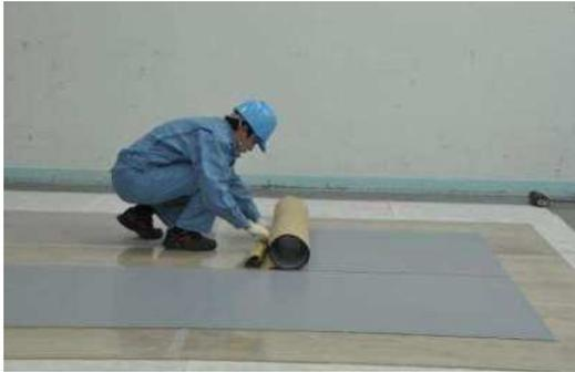
・ウレタン塗膜防水複絶縁仕様(複合工法): 通気緩衝シート張り付け
