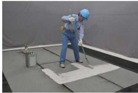
・改質アスファルトシート防水(アスファルト防水含む)露出仕様では、保護塗料を塗布して施工終了
