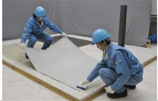
・塩ビシート防水接着工法: オープンタイムを取り、接着剤のべたつきがなくなったらシートを張り付ける
