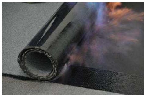
・トーチ工法: ラップ部からはみだしアスファルトを確認しながら施工する
