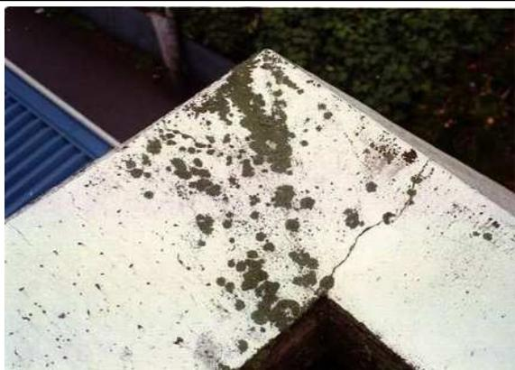
・パラペット天端:新築時に誘発目地が設けられなかったため、クラックが生じてしまった事例
