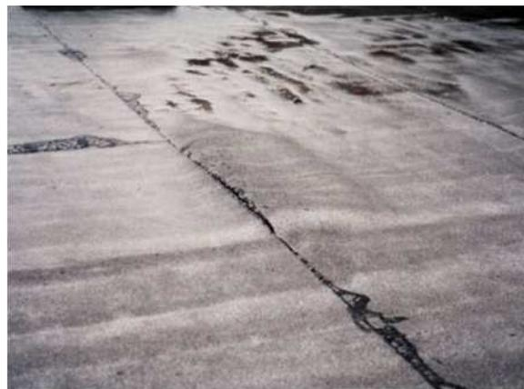
・平面部:下地からの湿気により防水層が押し上げられ膨れた事例
