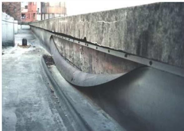
・立上り部:防水層へのアングルの掛かりが不足し立上り防水層がずれ落ちた事例
