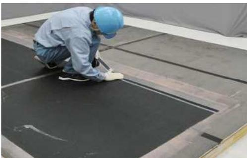
加硫ゴムシート防水: ジョイント部のテープ材処理
