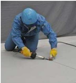
・塩ビシート防水接着工法: 熱風溶着機によるシート相互の接合
