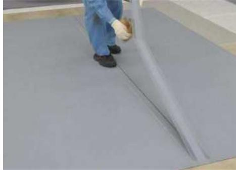
・ウレタン塗膜防水絶縁仕様(複合工法): 通気緩衝シートのジョイント部テープ張り
