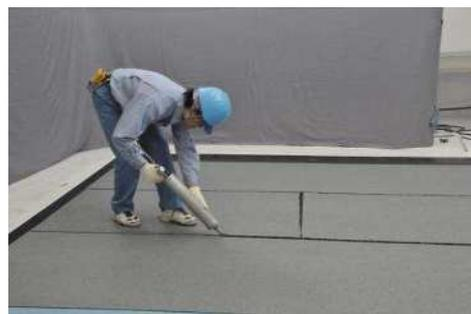
・常温粘着工法: ラップ部のシール処理
