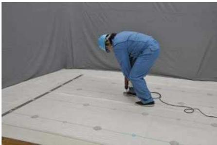
・塩ビシート防水機械的固定工法: ディスクをビスで固定
