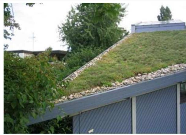
・勾配屋根の全面緑化:雨水の速やかな排水に配慮し、端部には砂利が敷き詰められ、先端部は大きな排水孔が設けられている
