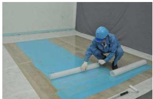
・ウレタン塗膜防水補強密着工法: 補強メッシュ敷込み
