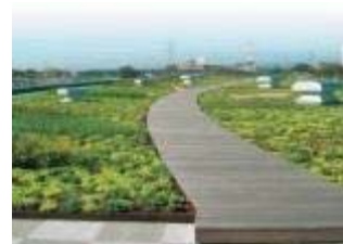
写真 1-6 セダムによる薄層緑化
