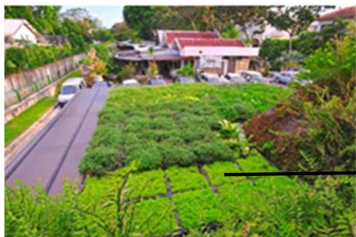
写真 1-5 緑化システム貯留層一体型の例
