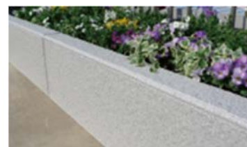
写真 4-7 見切り材設置状況
