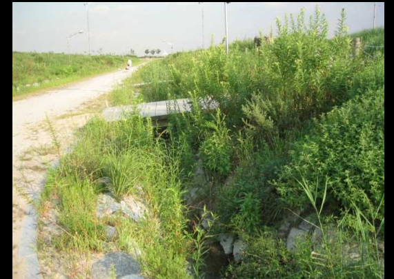
生態系に配慮した自然側溝
