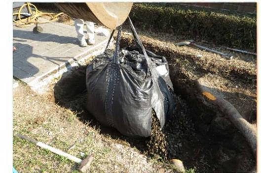
2. 路床部を掘削し、パワーミックスV（プレミックスタイプ）を充填。
