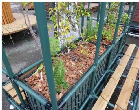
・雨水貯留の緑化コンテナと組立て式パイプ
