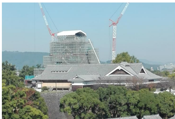
熊本城の復旧状況
