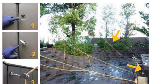
写真7 台風時のロープ張りによる補強
