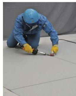
熱風によるジョイント部の溶着
