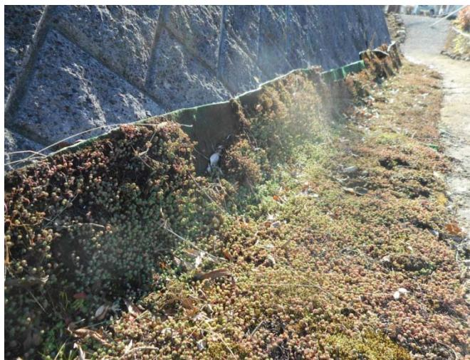
写真 16 マット栽培したセダムの敷設
