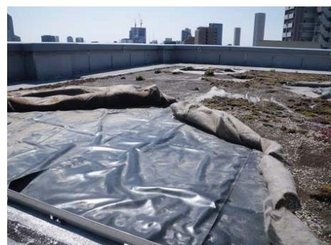
風により客土付植栽マットが飛散した薄層緑化
