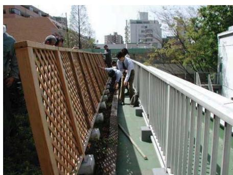
風により倒壊したフェンス
