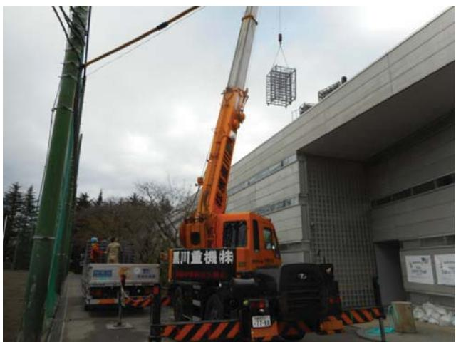
写真13 薄層緑化ユニットの搬出時
