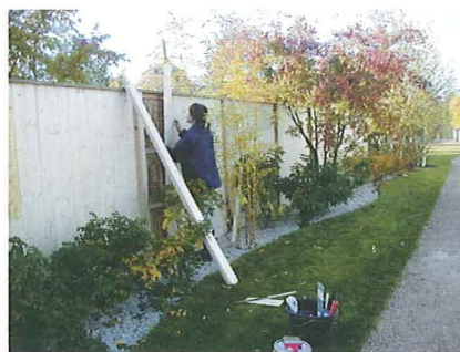
庭園補修工事
