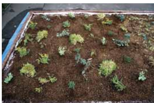
写真 4 セダム株植え付け
