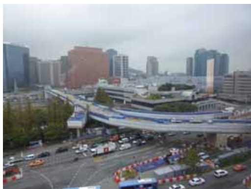
写真 28・工事現場全景
