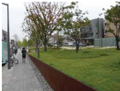
写真 18・鉄の土留め
