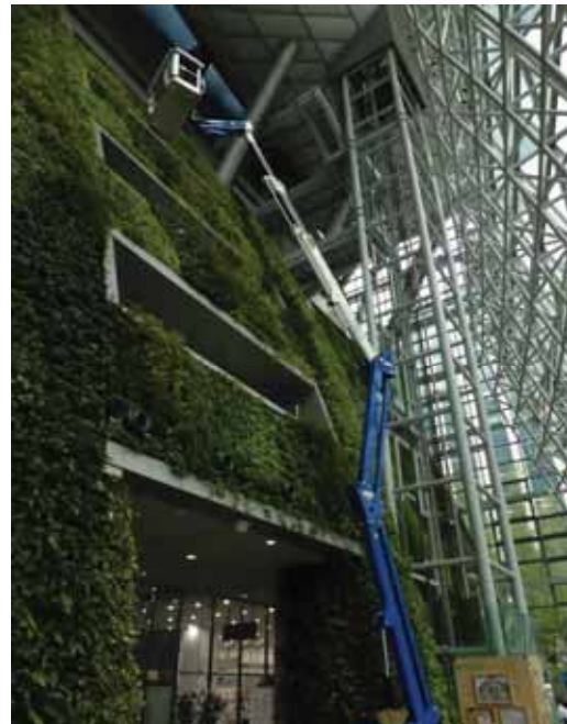
写真 4・油圧式多屈折作業車による作業
