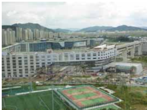
写真 11・全景（2014 年工事中）
