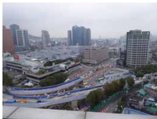
写真 29・ソウル駅と工事現場全景
