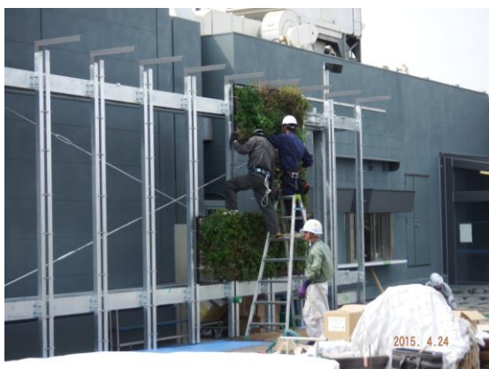
写真 6-7 壁面緑化パネル取付の様子
