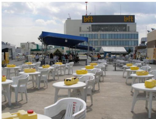
写真1 改修前現況（北側より南面）
