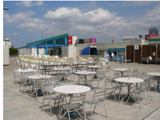
写真2 改修前現況（南側より北東面）
