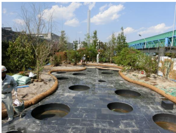
写真 4 睡蓮鉢設置用の釜場
