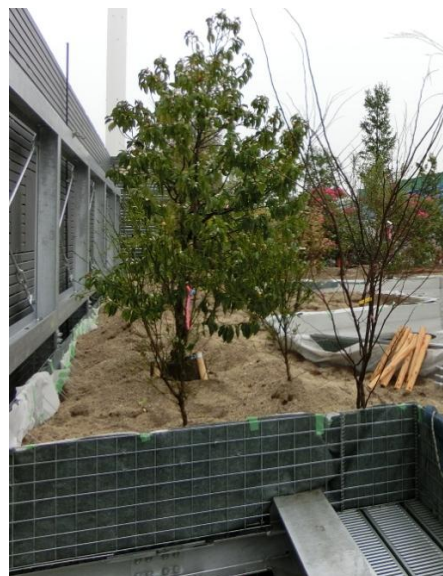
写真 5 植え込み土留め
