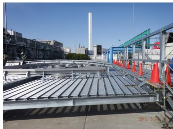
写真3 池と緑地を支える鉄骨架台
