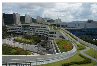
写真9 低層棟を俯瞰
