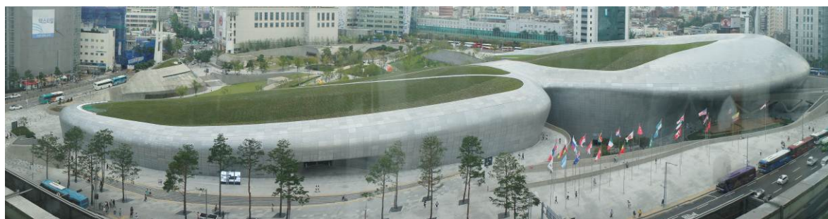
写真10 外観/近接のビルより俯瞰
