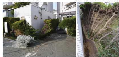
写真7 沈下による倒伏 写真8 根系露出
