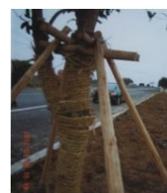
写真9) 四脚鳥居支柱
