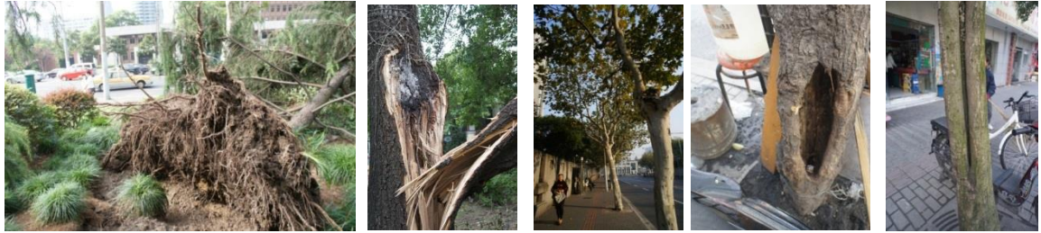
写真 14) 台風での倒木・写真 15) 入り皮写真・16) 異常な傾き・写真 17) 空洞写真・18) ラムズホーン
