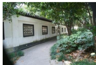
写真 22) 漏窓のある壁
