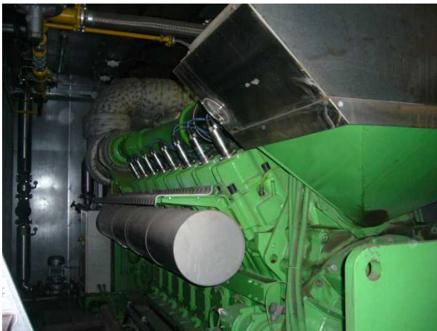
図6 CHP システム (Combined Heat and Power)
