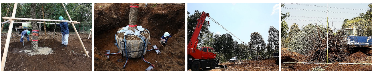
写真 17 地上支柱設置状況
