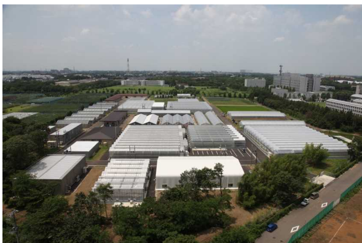
図8 TX 柏の葉キャンパス駅近くに立地する農林水産省植物工場千葉大学拠点施設
