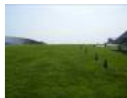
図 6 屋上緑化 D の全景
