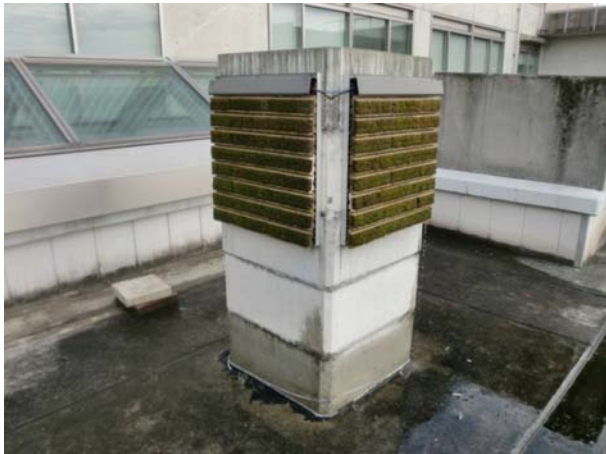
写真-3 スナゴケ壁面緑化資材
