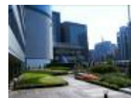
図 5 屋上緑化 C の全景
