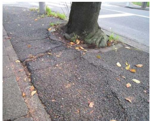
写真1 アスファルト歩道舗装の持ち上がりの例
