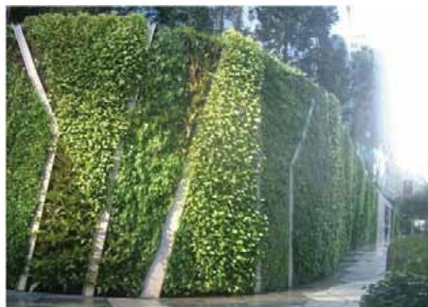
写真-7 基盤設置型壁面緑化
