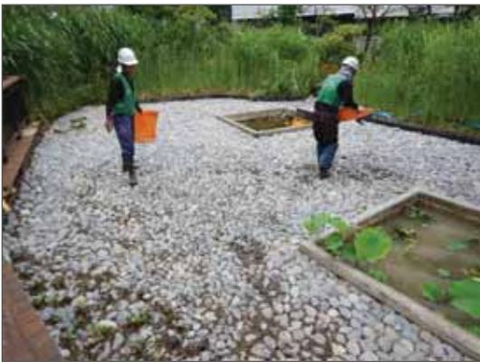
写真-10 ごろた石設置・目詰め砂利散布
