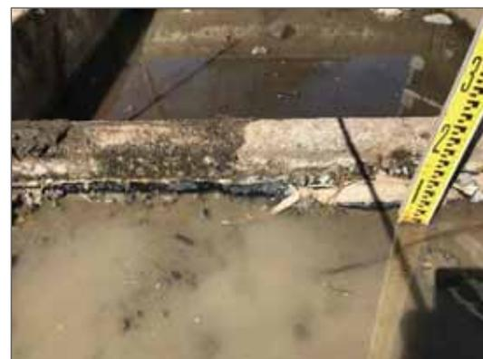
写真-2 防水層の溶出状況
