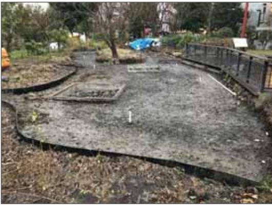
写真-9 堆積物除去後、整地・根侵入防止材設置
