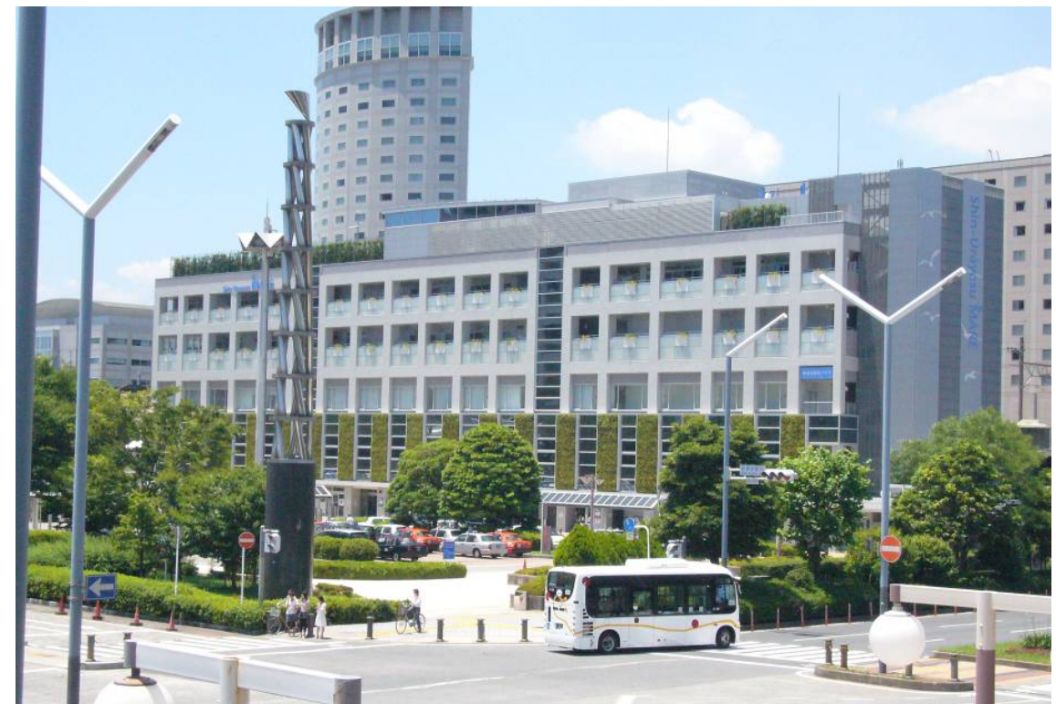
■新浦安駅前プラザ IL MARE の壁面緑化
