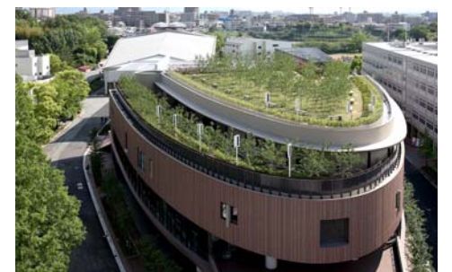
■関西大学総合学生会館 メディアパーク屋上広場
