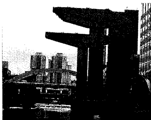
復元事業のシンボルとして、橋脚存置
