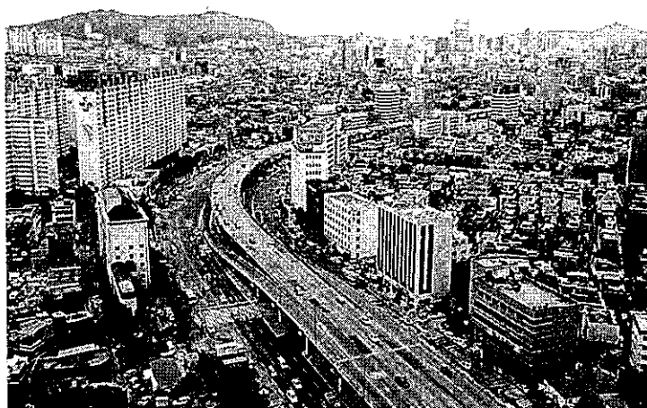
復元前。 清溪川の上に高架道路が 設置されている。
