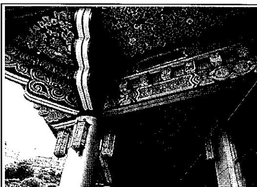
コモドホテル玄関のクラシックな天井
