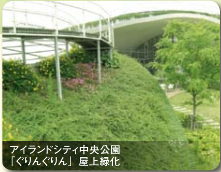
アイランドシティ中央公園「ぐりんぐりん」屋上緑化 自由曲面で急勾配な屋根の緑化は、植栽基盤を安定させる最新技術により可能になりました。
