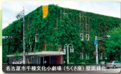
緑にすっぽりと覆われた環境都市名古屋のシンボル ヤシ繊維マットと補助資材を使い、建物壁面がすっぽりとつる植物で覆われています。
