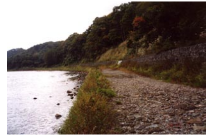
●水辺緑化工法事例(山形県・最上川): 根固工、水制工などの天端に土壌を投入し、植生の自然な復元を目指す盛土(石)による緑化工法(写真左: 施工直後、写真右: 施工3年後) 【出典】(財)都市緑化技術開発機構 グランドカバー共同研究会編(2000): グランドカバー緑化ガイドブック
