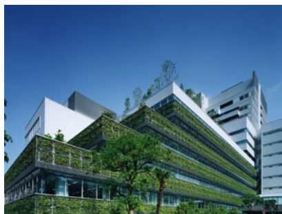
●土壌と補助資材を一体化したユニットにヘデラを植栽・養生して緑化した二番町ガーデン(東京都千代田区) 【出典】(財)都市緑化技術開発機構 特殊緑化共同研究会(2006): 知っておきたい壁面緑化のQ&A
