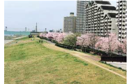
●スーパー堤防に千本桜を植栽した荒川(東京都江戸川区) 【出典】荒川下流河川事務所 HP
