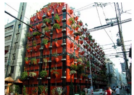
●プランターに樹木を植栽したオーガニックビル(大阪府大阪市) 【出典】(財)都市緑化技術開発機構 特殊緑化共同研究会(2006): 知っておきたい壁面緑化のQ&A
