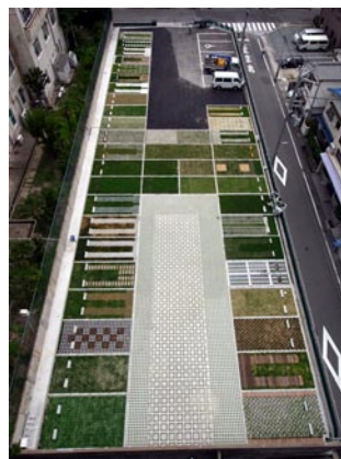
●グラスパーキング推進事業を進めている福祉センターの駐車場(兵庫県神戸市) 【出典】兵庫県県土整備部 HP
