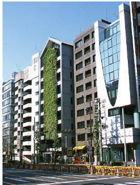
●格子状フェンスを用いて緑化した松永ビル(東京都港区) 【提供】開光不動産有限公司
