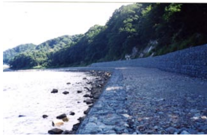
●水辺緑化工法事例(山形県・最上川): 根固工、水制工などの天端に土壌を投入し、植生の自然な復元を目指す盛土(石)による緑化工法(写真左: 施工直後、写真右: 施工3年後) 【出典】(財)都市緑化技術開発機構 グランドカバー共同研究会編(2000): グランドカバー緑化ガイドブック
