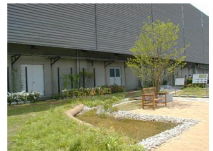
● 合同庁舎3号館屋上庭園の流れ(東京都千代田区)
