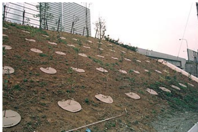
●古紙から作られたペーパーマルチによる高速道路の緑化(神奈川県秦野市) 【出典】ダイトウテクノグリーン HP
