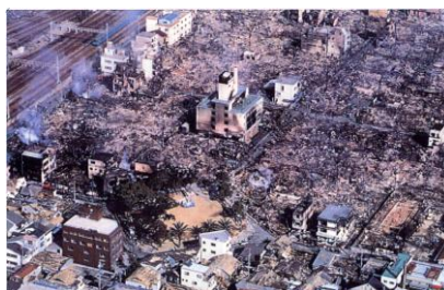
●阪神淡路大震災時に延焼防止効果を発揮した大國公園(兵庫県神戸市) 【提供】国土交通省
