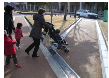
●段差が解消された歩道
