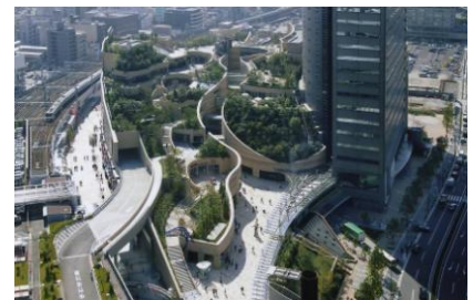
●都心部のシンボルとなっているなんばパークス パークスガーデン(大阪府大阪市)(屋上・壁面・特殊緑化技術コンクール受賞作品)
