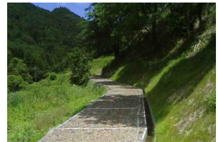
●チップ材をマルチングとして使用している国営飛鳥歴史公園(奈良県高市郡明日香村)
